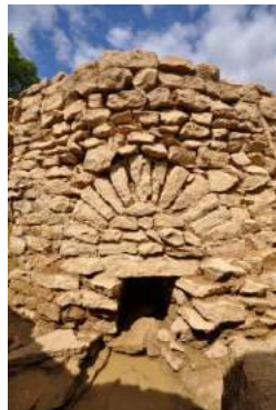
Passage d'une canalisation sous le temple principal.
