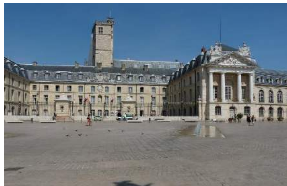
Place de la Libération, Dijon, 5000 m2 de Comblanchien
